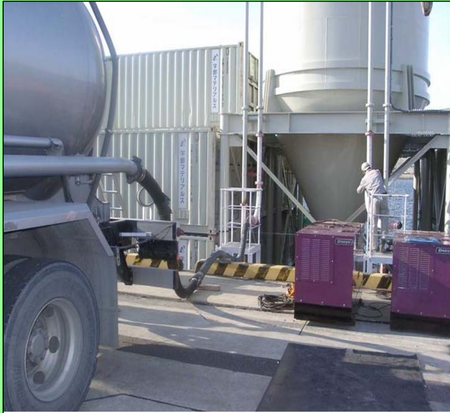
粉状生石灰 積み込み
