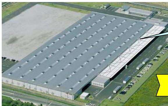
物流センターの屋根
